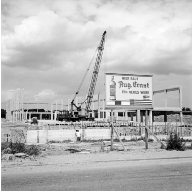
Bau des neuen Gebäudes für die Firma August Ernst, 1970
