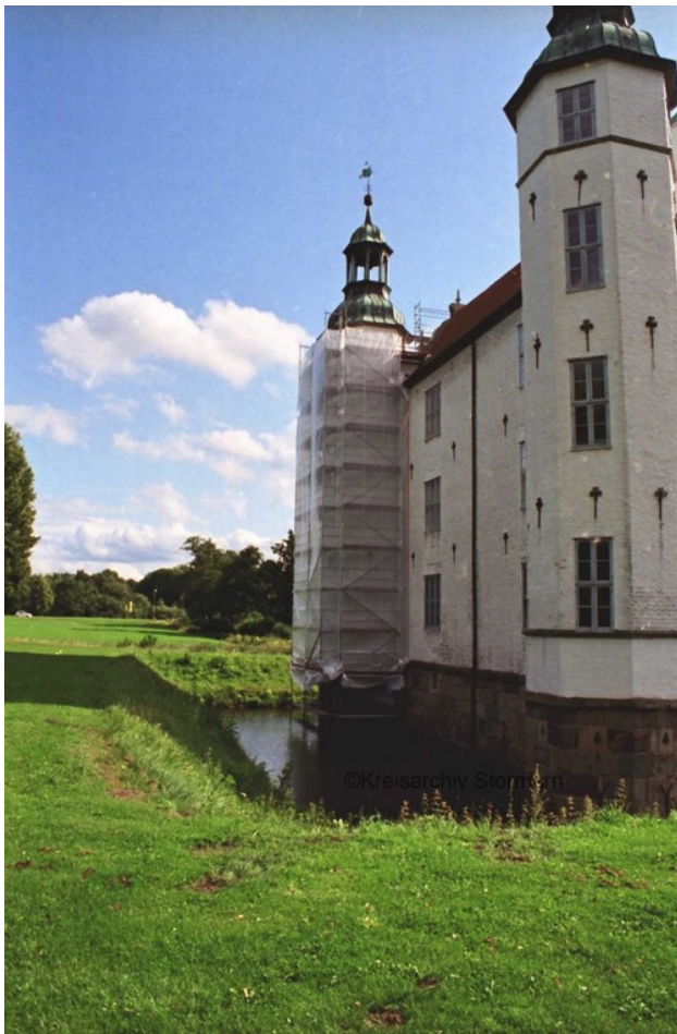
Südostturm eingerüstet während der Sanierung der Außenfassade, 2009
