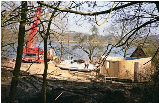
Baustelle für Seminargebäude, 2009
