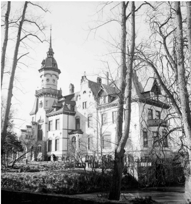
Ansicht von Südosten mit noch erhaltenem Ostflügel, 1957
