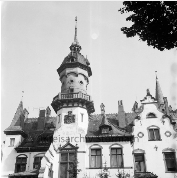
Giebelfront mit Turm, Ansicht von Süden, 1980
