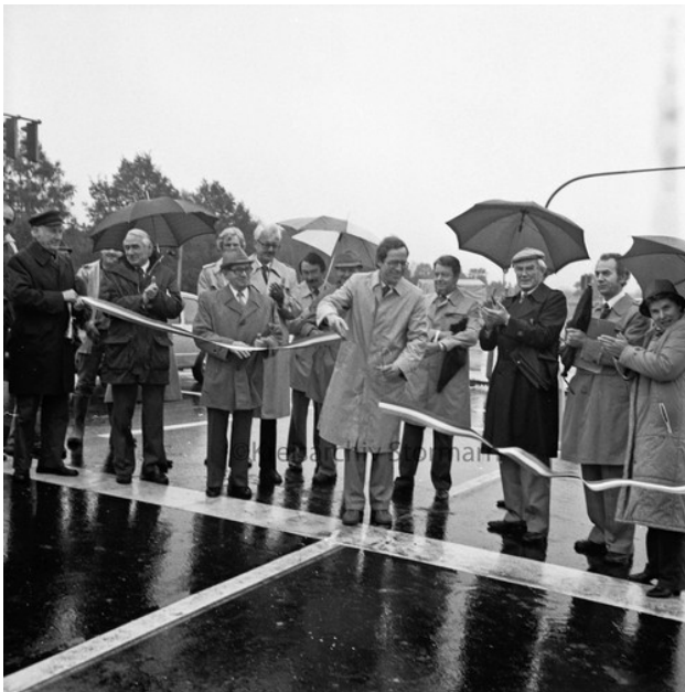
Freigabe der Kreisstraße 80 in Glinde, 1983
