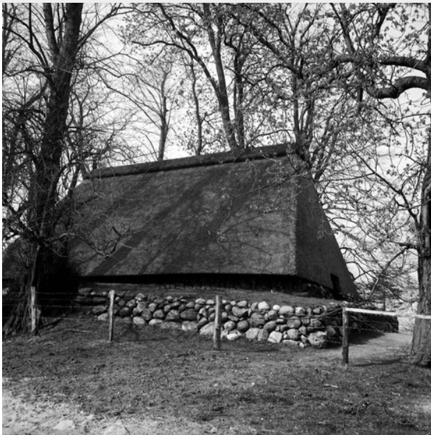
Eiskeller nach der Restaurierung, 1985
